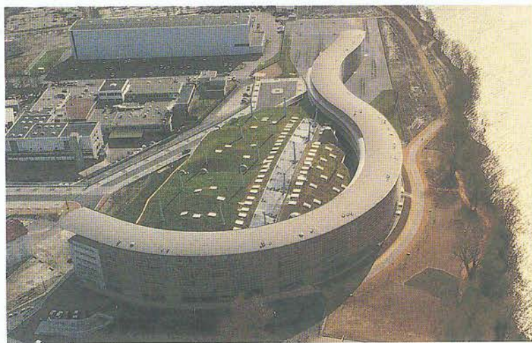
Page 138 and 139 Cité Scolaire Interna- tionale de Lyon Jourda and Perraudin Lyon, France 1989-92
